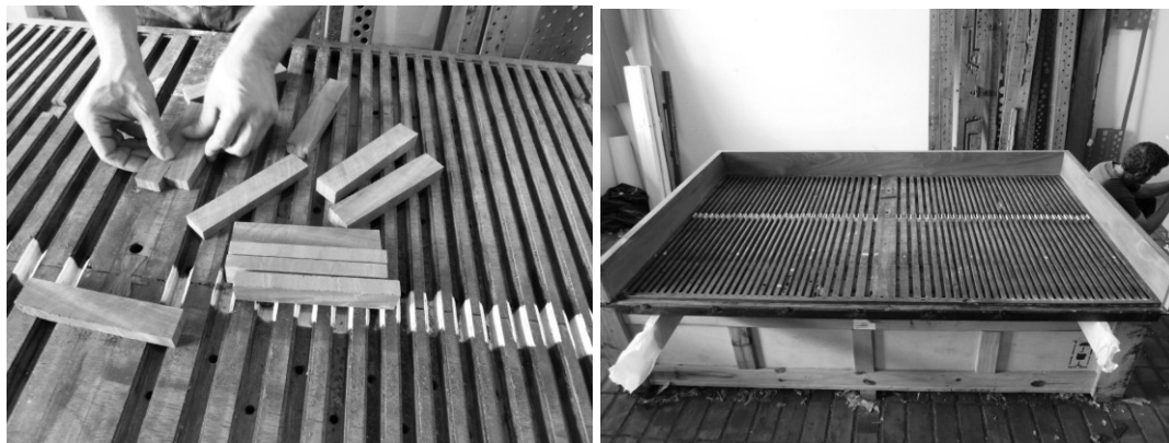
Fig. 9 – Restauração dos canais do someiro e colocação dos novos costados.
